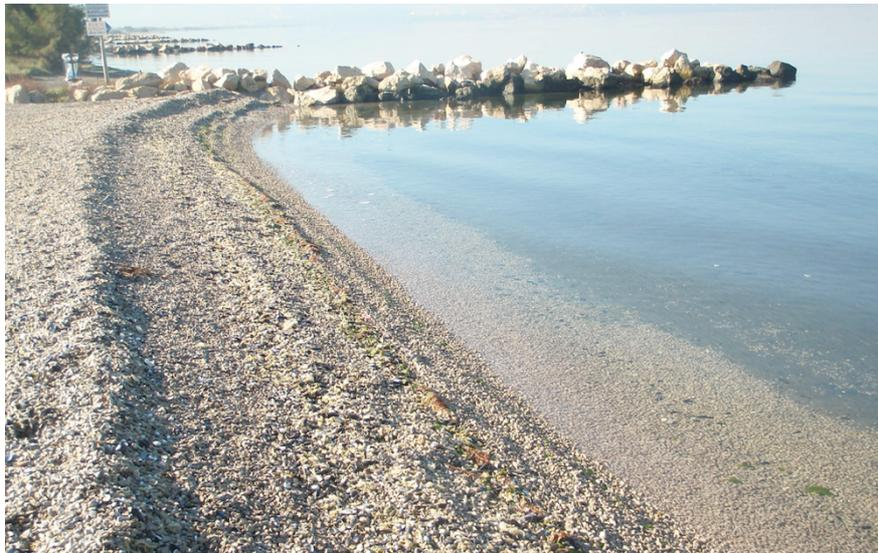
Photo. 21. Les dépôts de gravillons depuis le dernier épi vus vers le SW. La pente du jet de rive est plus prononcée avec les gravillons que sur la plage naturelle sableuse. Les gravillons « descendent » aussi sous l'eau mais sans aller plus au large vers la zone du déferlement (cliché F. Sabatier, Aix-Marseille Université, CEREGE, 2009).
