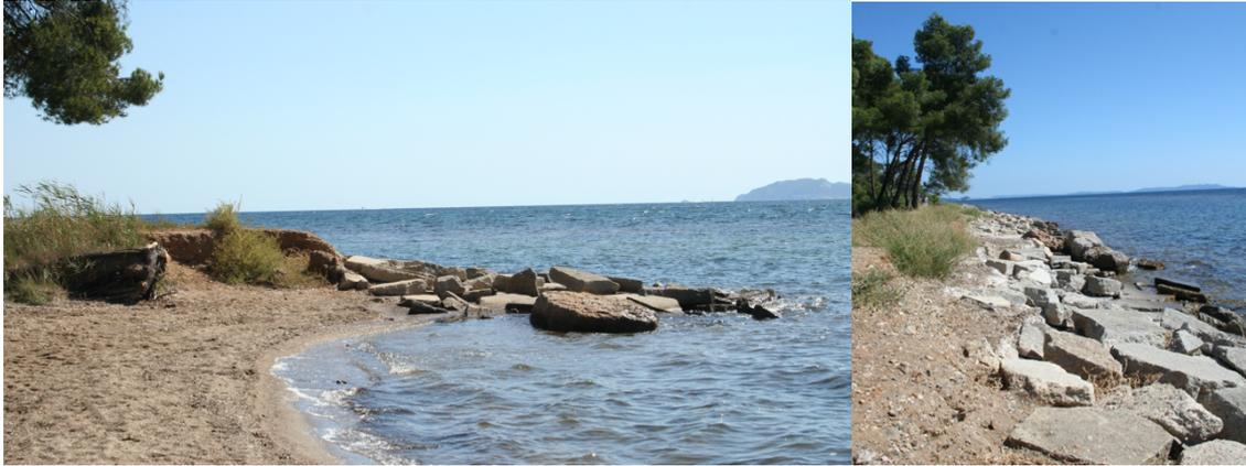
Photo. 7. La digue désenrochée en 2011. Les matériaux utilisés correspondent à des blocs déposés plutôt « en vrac », assez éloignés de recommandations de génie côtier (F. Sabatier, Aix Marseille Université, CEREGE).
