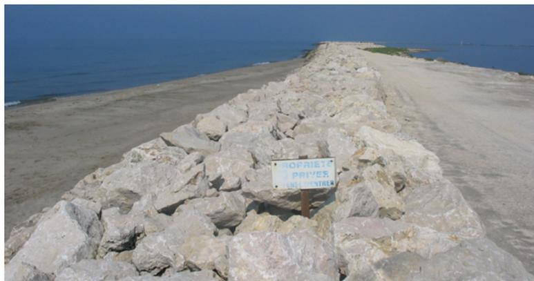
Photo. 1. La digue de Véran en 2005, vue vers l'ouest depuis son extrémité est. Un lambeau de plage existe encore, à l'abri du dernier épis (au dos de la photo). Sur la droite de la digue, l'étang de Véran, profond de quelques dizaines de centimètres est aujourd'hui comblé par près de 0,5m de sédiments. On distingue un ancien dépôt d'overwash lié à la tempête de 1997 (cliché O. Samat).
