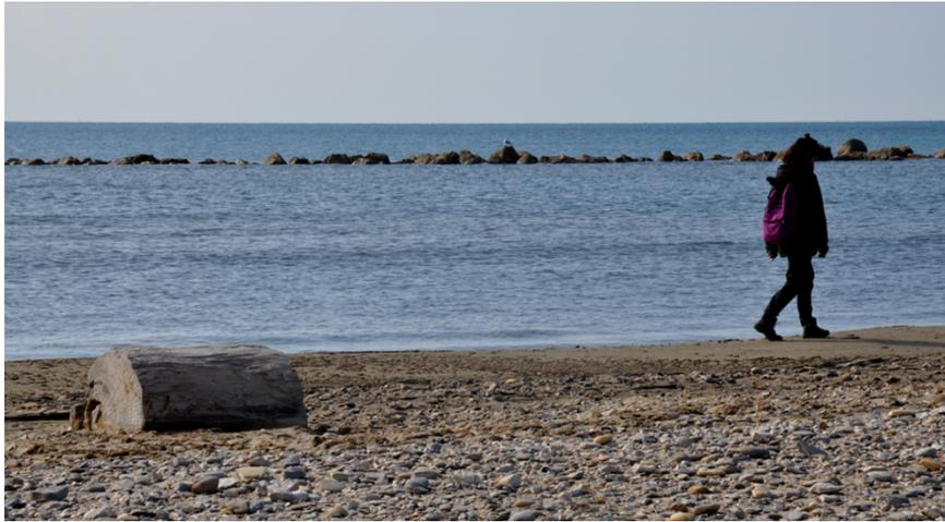
Photo. 5. En 2021, à l'ouest du site il ne subsiste plus que les blocs de la carapace de la digue qui s'enfoncent progressivement dans le sable. Le rivage a reculé de presque 100 m. Au premier plan on distingue des vestiges (galets et petits blocs) de la route carrossable de la digue (cliché P. Laroudé).
