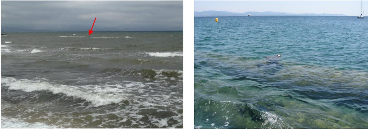
Photo. 10. Gauche : on distingue une ligne de déferlement au large induite par les boudins en géotextiles dans des conditions de faible énergie correspondant à Q50. Droite : les boudins en géotextiles visibles par transparence dans des conditions estivales (clichés F. Sabatier, Aix-Marseille Université, CEREGE, 2016).
