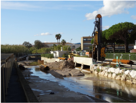
Aménagement du lit du Batailler, Photographies personnelle, Lavandou, 2020
