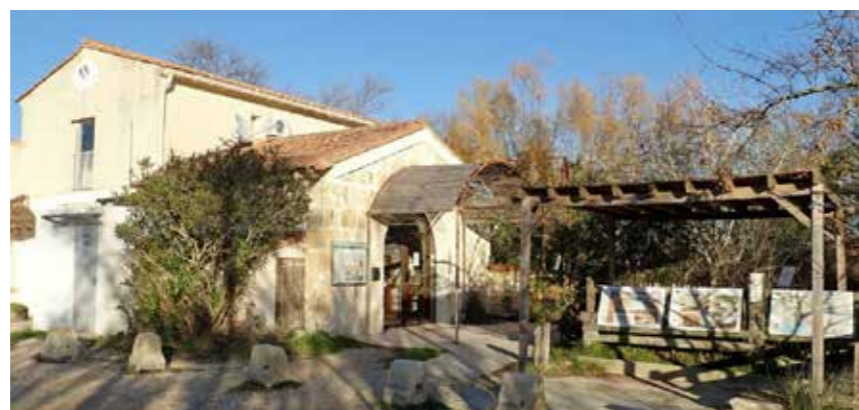
Mas de la Capelière - Centre d'information du parc
