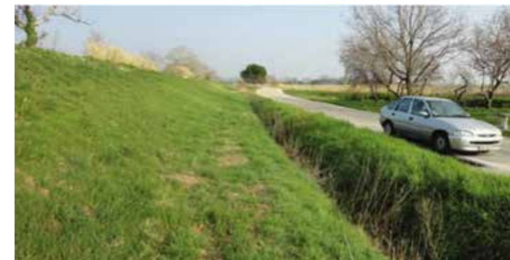
Digue du Petit Rhône
