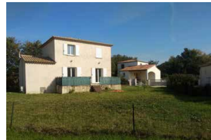
Les maisons sont surélevées d'1 m
