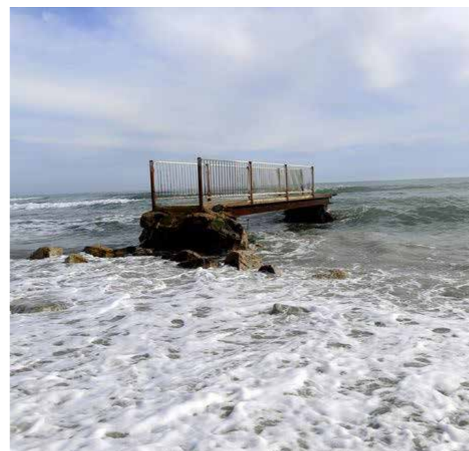
Cette passerelle se retrouve dans la mer
