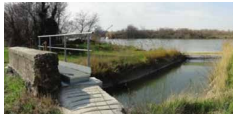
Prise d'eau sur le Petit Rhône
