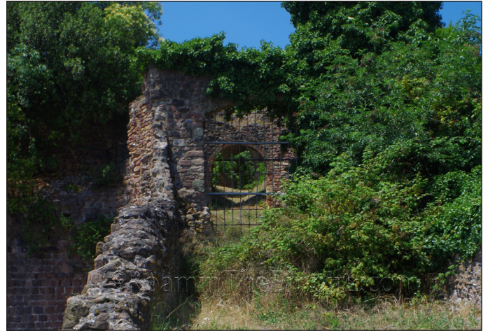
Vue intérieur de la tour Augustan
