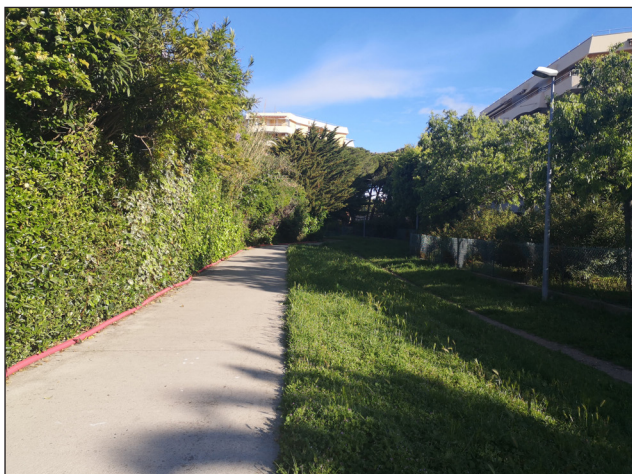
Tracée du canal qui longe un espace perméable
