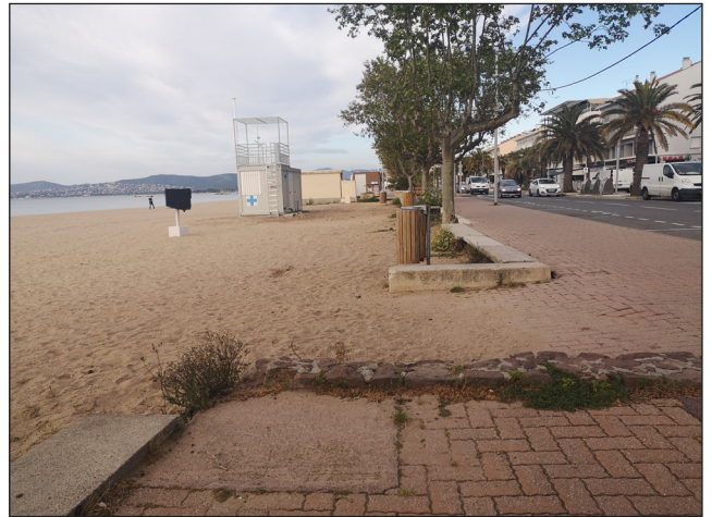
Accès à la plage par une rampe
