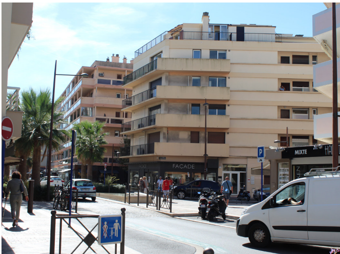
Une forte présence de la voiture sur l'avenue Jean-Jaurès, un axe majeur vers la plage depuis le centre-ville
