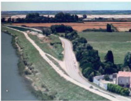
Digue du Petit Rhône
