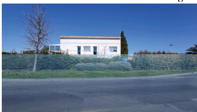
4 - Route de la gare
