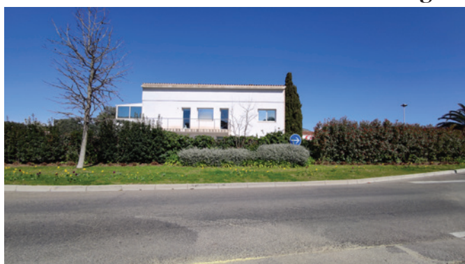
4 - Route de la gare
