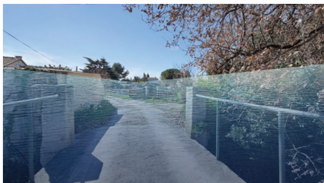
10 - Pont de la Reppe
