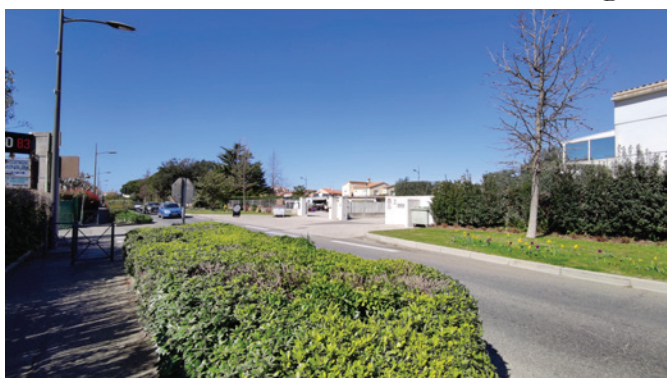
5 - Route de la gare
