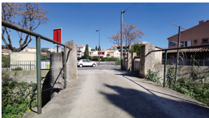
9 - Pont de la Reppe
