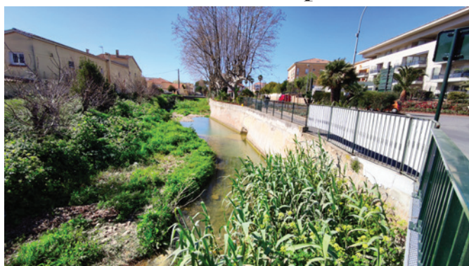
24 - Traverse de la Reppe
