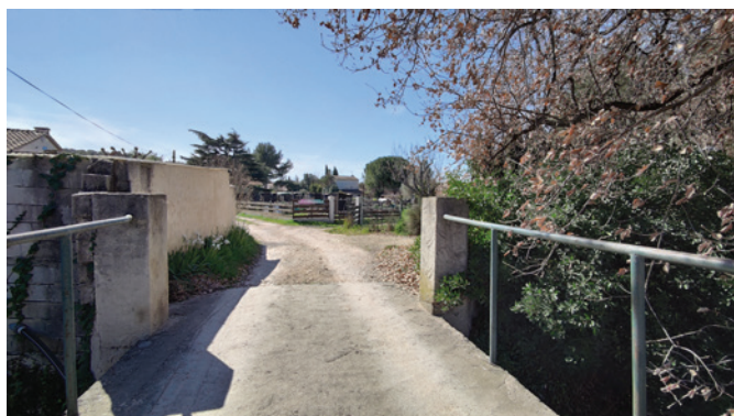
10 - Pont de la Reppe
