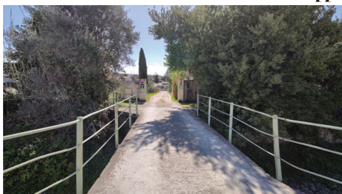
12 - Pont de la Reppe
