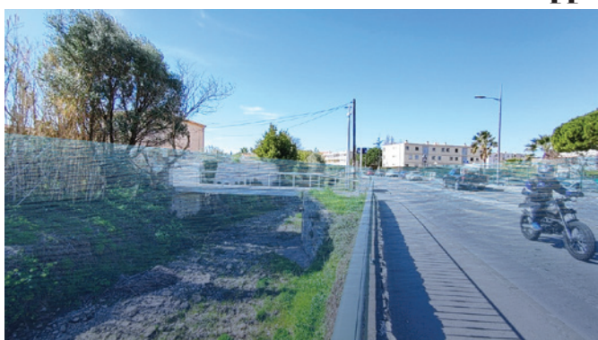
11 - Route de la gare et lit de la Reppe
