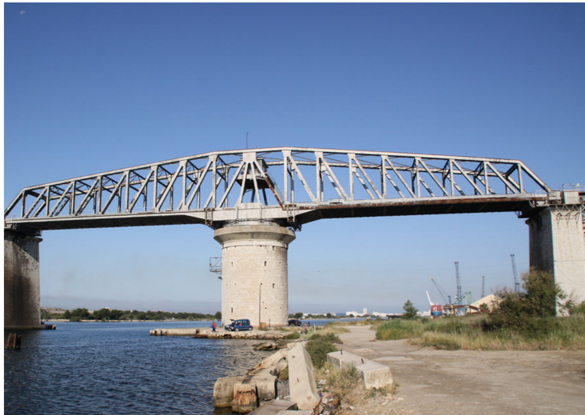
Pont de Caronte 1908 / 1952
