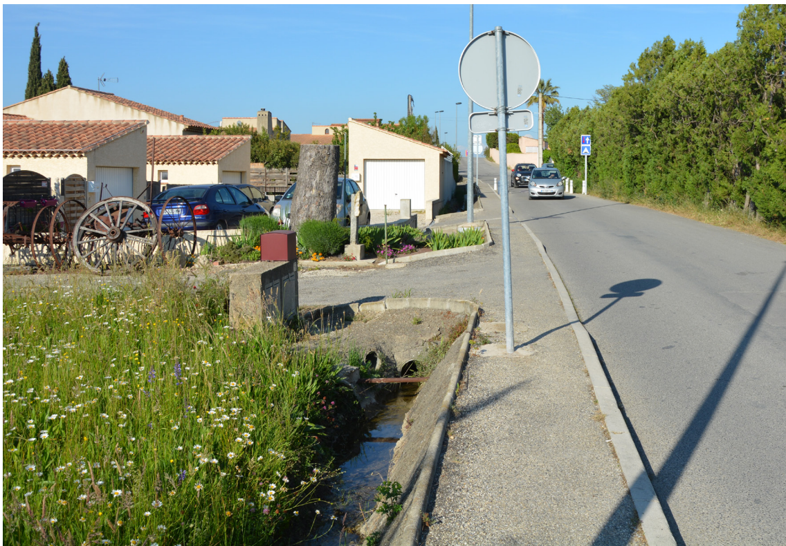
Le canal apparent contre la voirie
