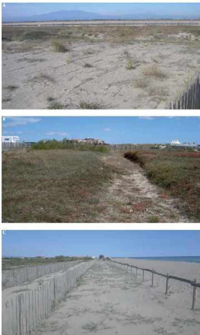
Figure 3.5. Exemples de restauration de cordon dunaire par actions de contrôle souple, dans les Pyrénées-Orientales à Canet-en-Roussillon et à Toreilles.
