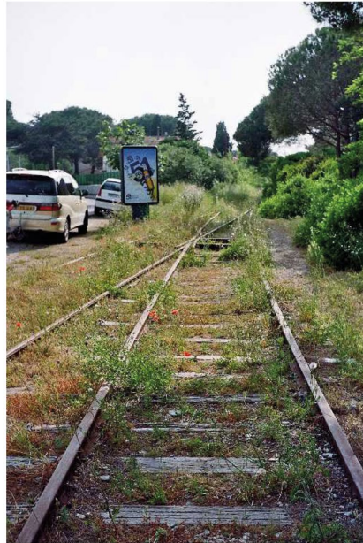
REMISE EN SERVICE DE LA VOIE FERRÉE DÉSFFECTÉE
